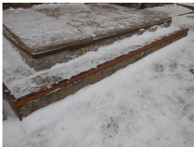
Фото 6 Лестница наружная главного входа
