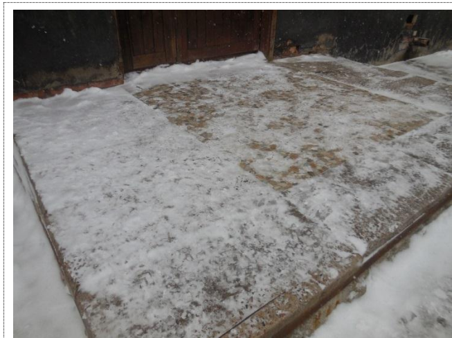
Фото 7 Входная площадка главного входа
