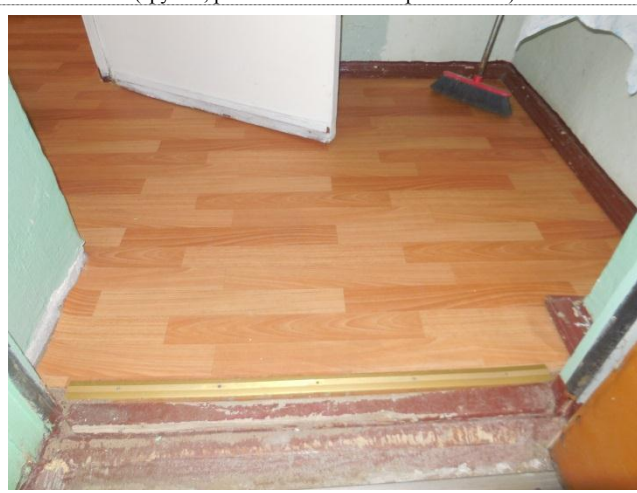
Фото 16 Внутренняя входная дверь (группа, расположенная на первом этаже)
