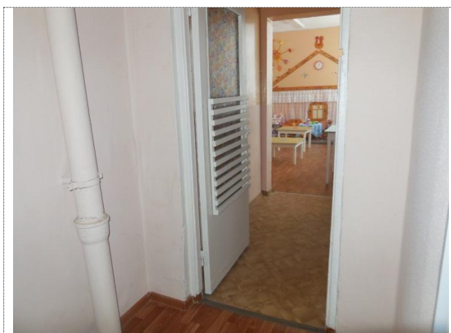
Фото 22 Пути движения внутри здания (двери)
