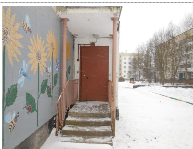
Фото 12 Лестница наружная (группа, расположенная на первом этаже)
