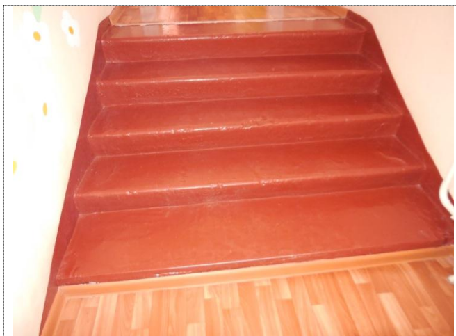
Фото 20 Пути движения внутри здания (лестницы)
