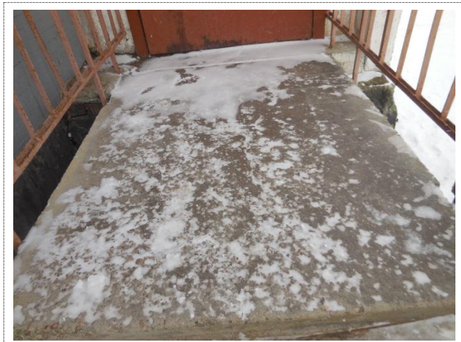
Фото 13 Входная площадка (группа, расположенная на первом этаже)
