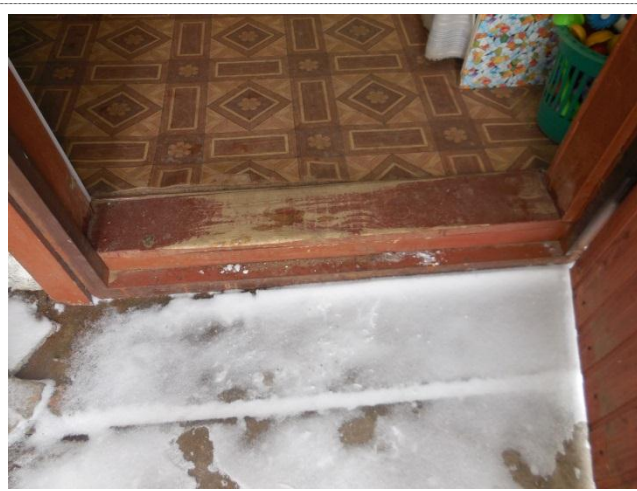
Фото 14 Наружная входная дверь (группа, расположенная на первом этаже)
